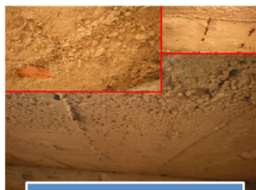
改造前水箱內頂部
