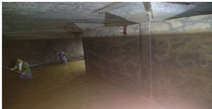
蓄水池排水及池壁清洗
