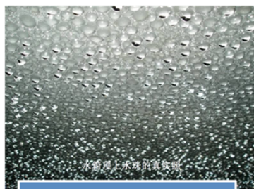
改造后水箱內頂部
