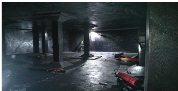
滾塗施工完畢
