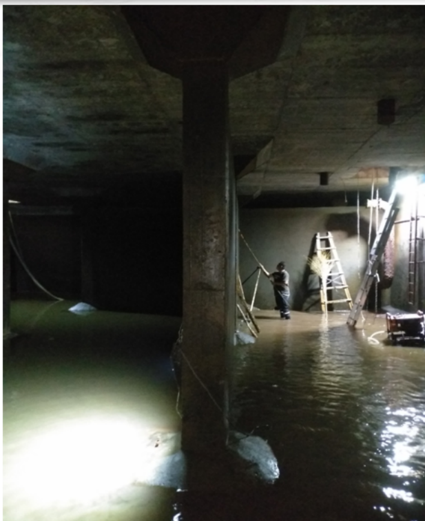
蓄水池排水及池壁清洗
